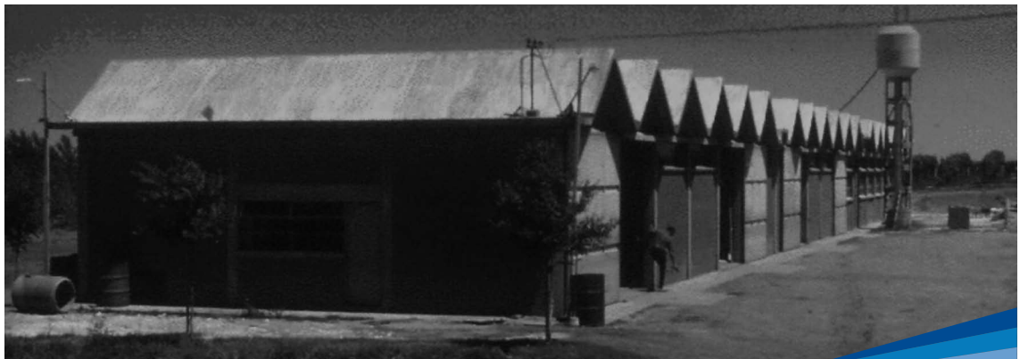
Primera edificación de galpones y oficinas
