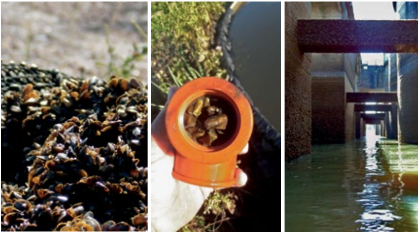
Figura 2. Colonias bentónicas de Limnoperna fortunei ocasionando incrustaciones: redes para acuicultura, macrofouling en infraestructuras de conducción hidráulica, presas hidroeléctricas.
