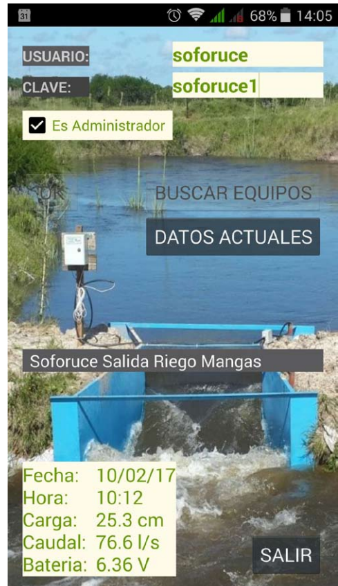
Figura 5-47 App Acceso Remoto de equipos de Acequia Innova
