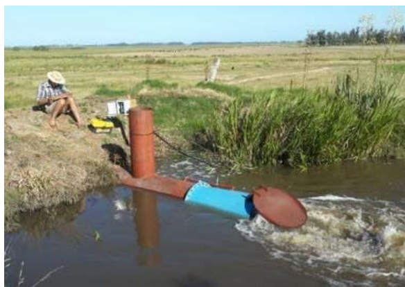
Figura 4-28 Placa de Orificio bombeo Glencore
