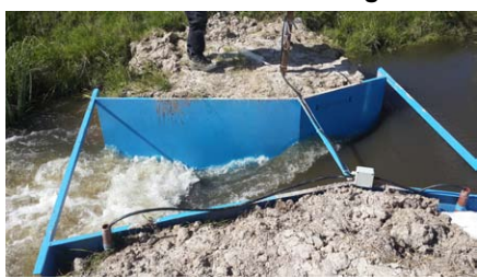
Figura 4-11 Sin Cuello 24 instalado
