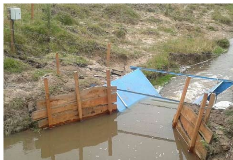
Figura 5-2 ACA con pantallas para eliminar los vórtices
