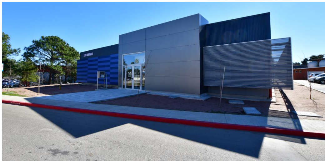
Estructura externa del edificio “Los Guayabos”.
