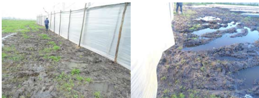
Figura 86. Problemas de encharcamiento provocados por dejar suelo desnudo alrededor de los invernaderos. Fotos D. Maeso
