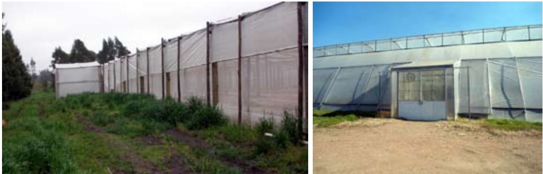
Figura 96. Diferentes diseños de doble puerta de entrada en invernáculos con malla. Fotos D. Maeso
