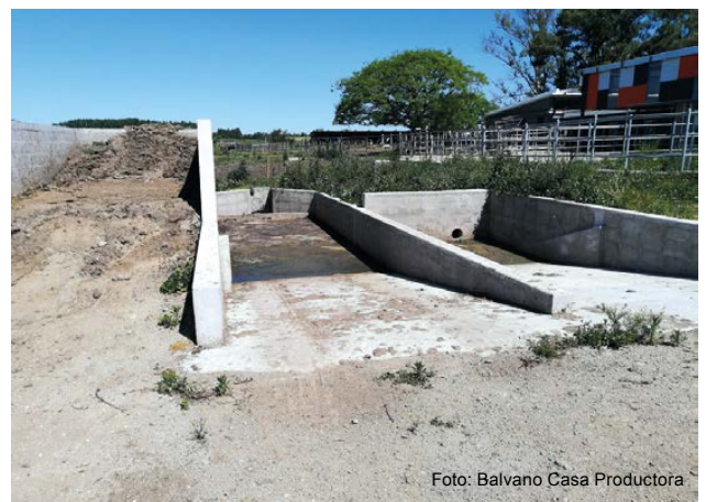
Figura 2 - Desarenador y separador de sólidos pasivo. Escuela Superior de Lechería de Nueva Helvecia, CETP-UTU.
