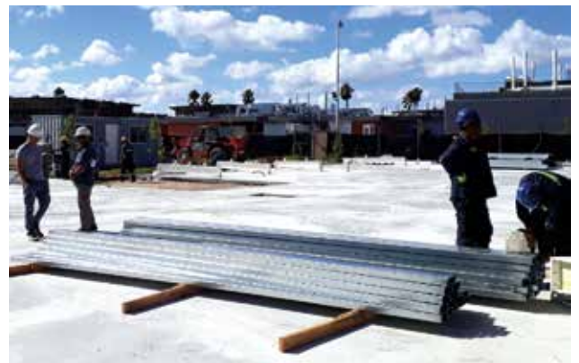
Figura 1 - Primeras etapas de la obra (26/2/2019).
