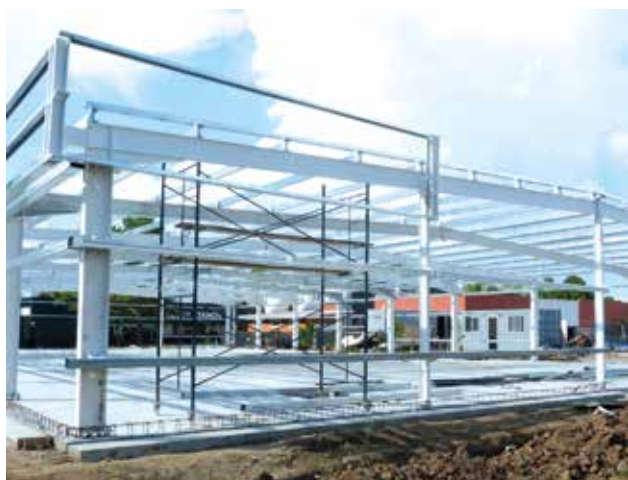
Figura 2 - Estructura del edificio (7/3/2019).
