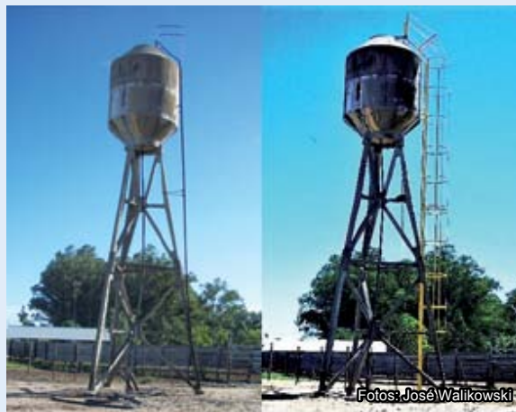
Figura 9 - Mejora de condiciones de trabajo. Tanque en Unidad del Lago: “antes” y “después” de la condición de acceso, apreciando los resguardos de seguridad implementados bajo norma técnica y legal (La Estanzuela).
