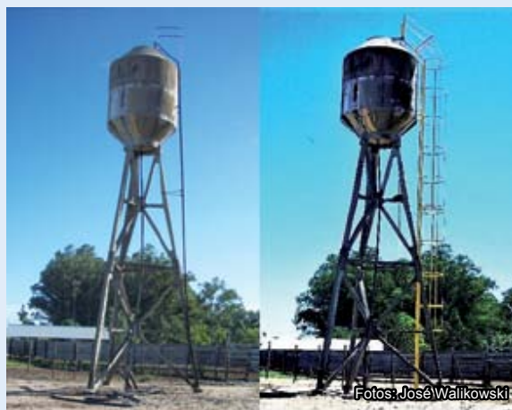
Figura 9 - Mejora de condiciones de trabajo. Tanque en Unidad del Lago: “antes” y “después” de la condición de acceso, apreciando los resguardos de seguridad implementados bajo norma técnica y legal (La Estanzuela).
