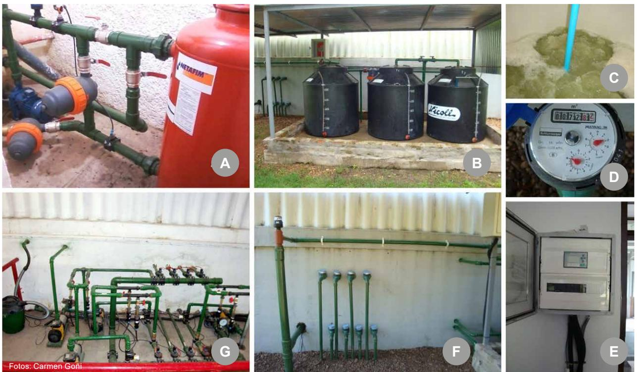
**Figura 1** - Plataforma del sistema de fertirriego. A: filtros, B: tanques y mezclador, C: mezclador de aire, D: contadores de caudal, E: sistema de control, F: contadores de agua para cada tratamiento y G: sistema de válvulas para cada tratamiento e inyección de fertilizante.
