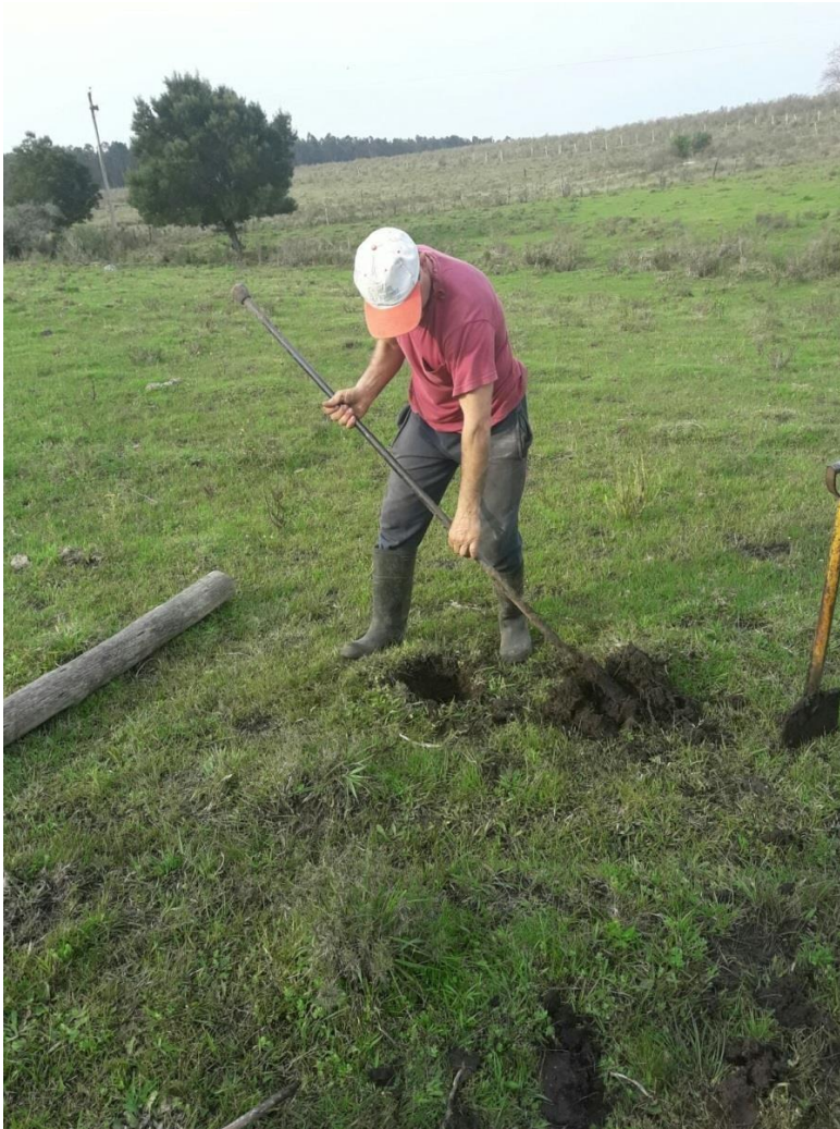
IMAGEN 6: Tareas de instalación de cerco eléctrico para delimitación de área riparia en predio de Cristina Ramos, Laguna del Cisne
