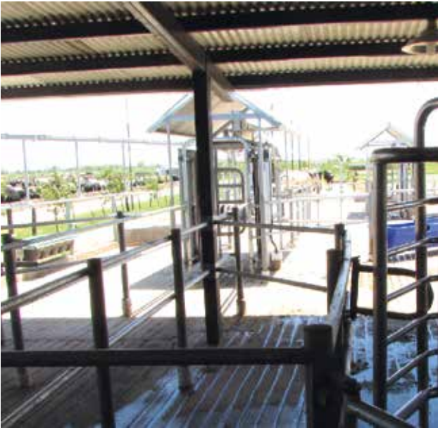
Foto 1 - Toma desde sala de ordeño hacia patio de espera. INTA-Rafaela
